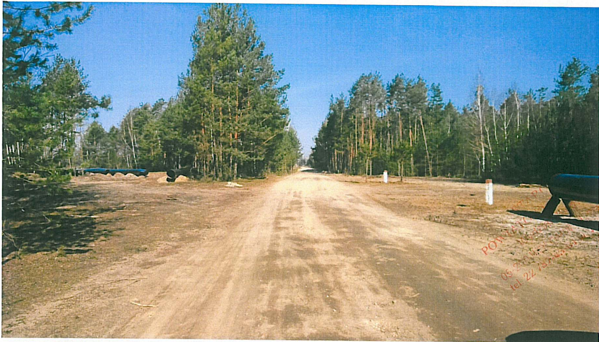
Zdjęcie 2 Droga powiatowa nr 4328W
