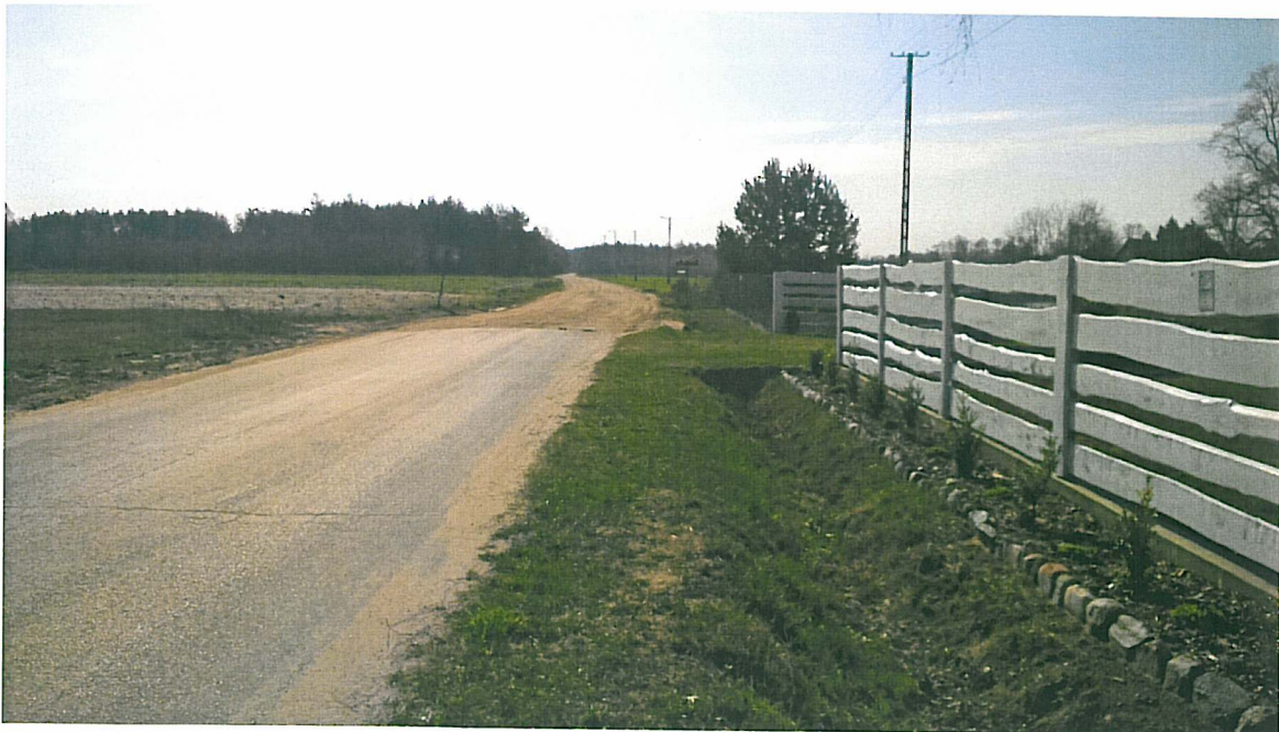
Zdjęcie 1 Istniejąca droga powiatowa nr 4328W o naw. asf.- początek inwestycji.
